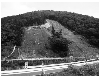
復旧作業が進む災害現場(朽木)
